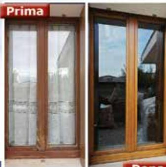
**RESTAURO E RIPARAZIONE SERRAMENTI CON SOSTITUZIONE VETROCAMERA
